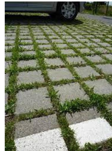
Exemple de stationnement perméable et enherbé
